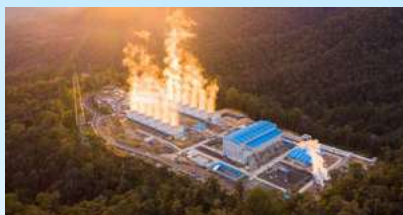
Pembangkit Listrik Tenaga Panas Bumi Geothermal Power Plant
